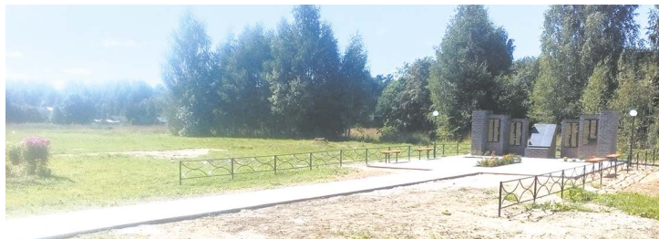
Благоустройство территории и монтаж наружного освещения около памятника воинам Великой Отечественной войны. Мышкинский район, село Охотино
