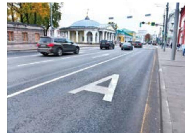
покрытие из крупноформатной плитки. Для повышения безопасности дорожного движения были установлены новые знаки, обновлены светофоры и нанесена горизонтальная дорожная разметка из термопластика со светоотражающими элементами. Обновили четыре остановочных павильона общественного транспорта. На объекте установлено дополнительное техническое оборудование – проекционные пешеходные переходы. Эти меры направлены на повышение безопасности дорожного движения, в особенности в зимний период.
